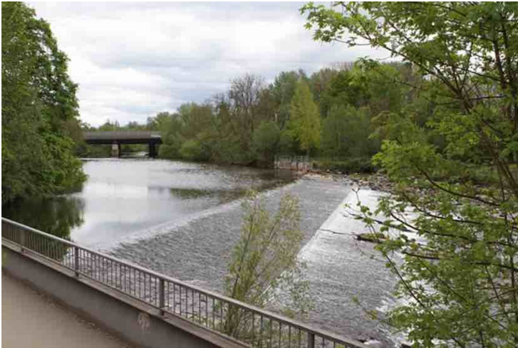
Abb. 91 Brücke Nr. 18, kurz vor der Siegmündung
