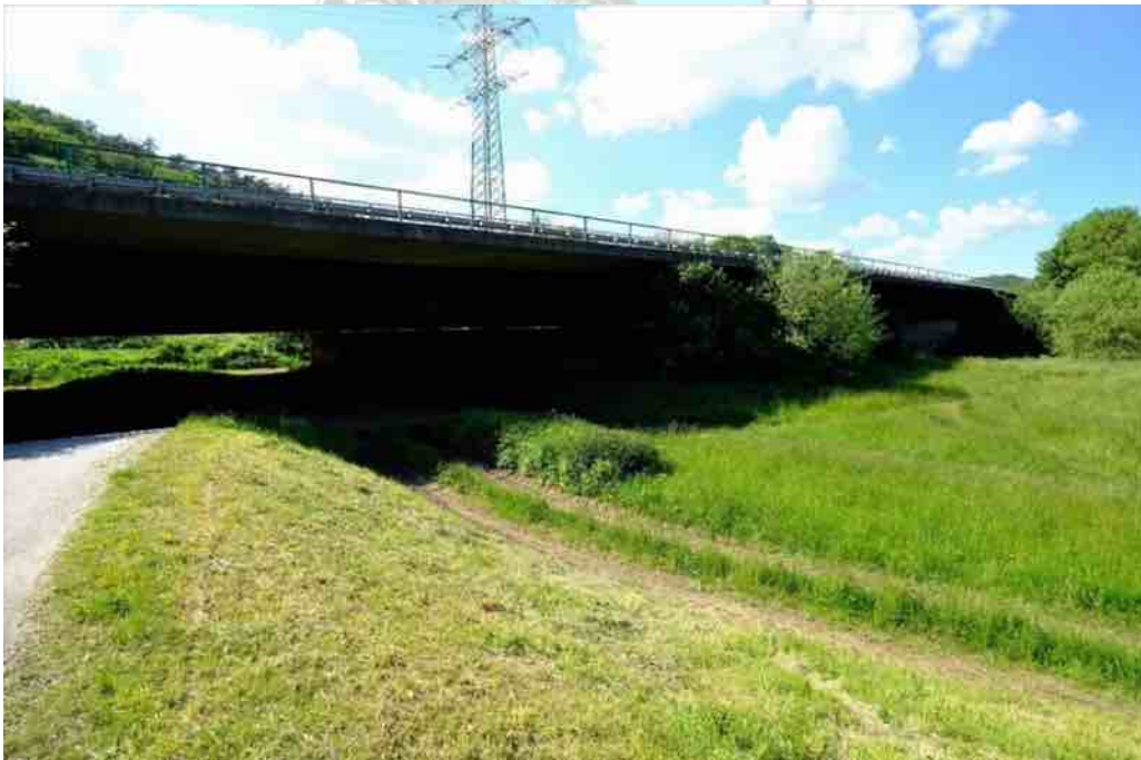
Abb. 86 Brücke Nr. 12 „Autobahnbrücke A 3“
