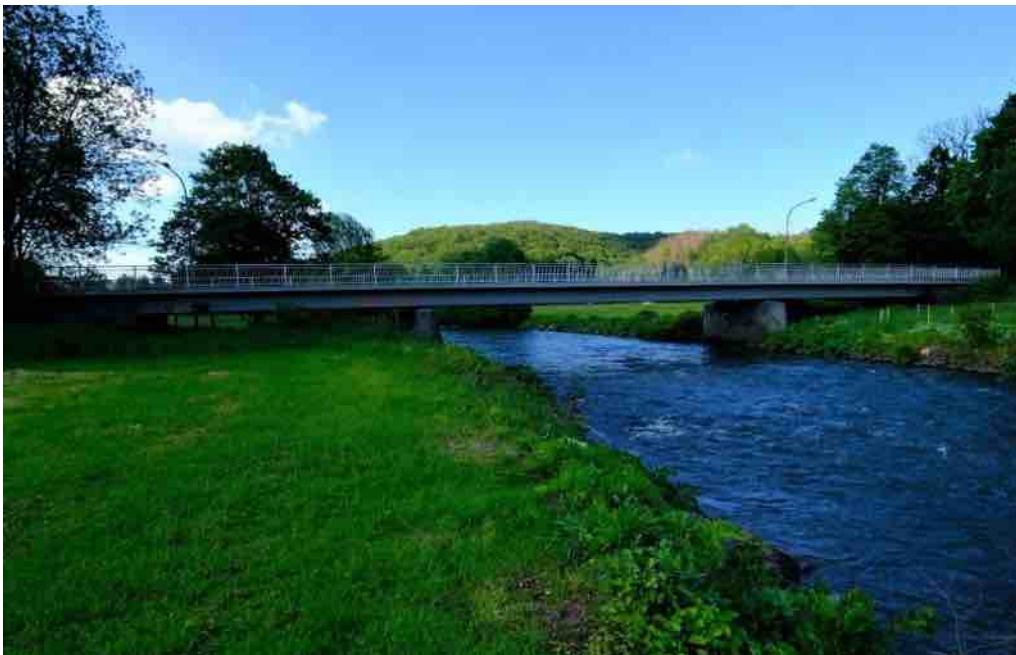
Abb. 72 Brücke Nr. 1 zwischen Bachermühle und Neuhonrath
