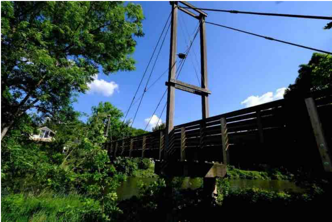
Abb. 82 Brücke Nr. 9 Fußgängerbrücke Donrath
