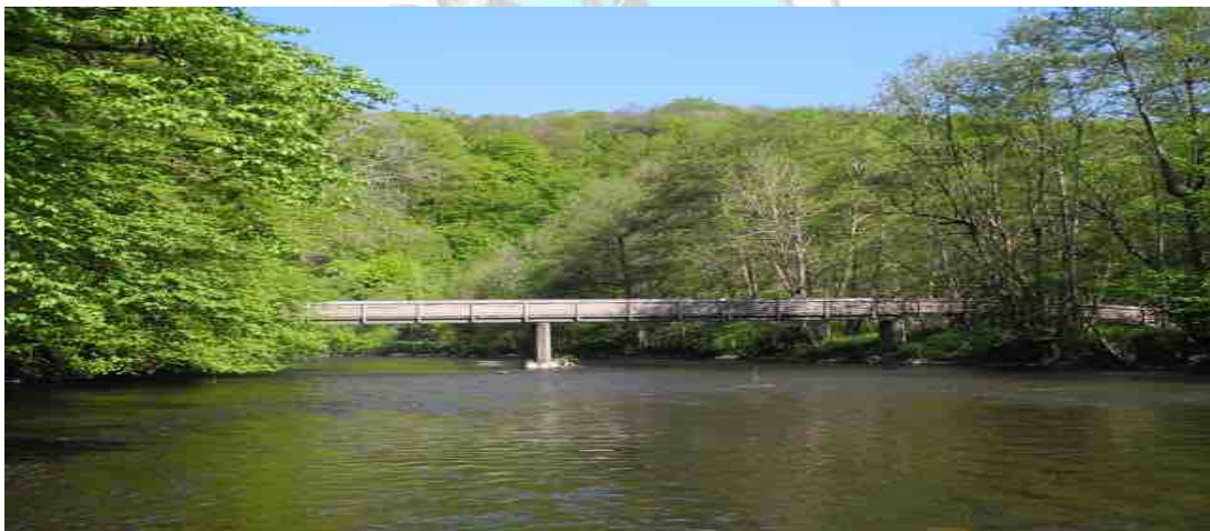
Abb. 81 Brücke Nr. 8 Fußgängerbrücke an der Dornhecke.
