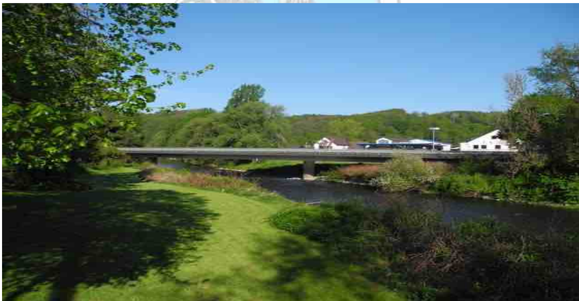
Abb. 74 Brücke Nr. 3 Bundesstraße 484
