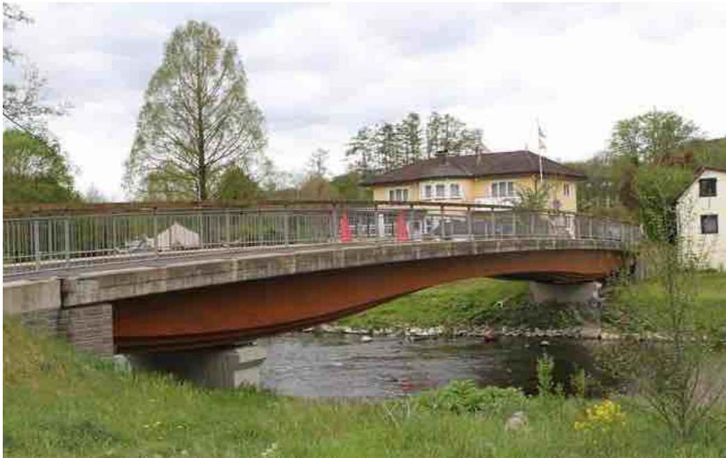
Abb. 77 Brücke Nr. 6 „Am Aggerschlößchen“
