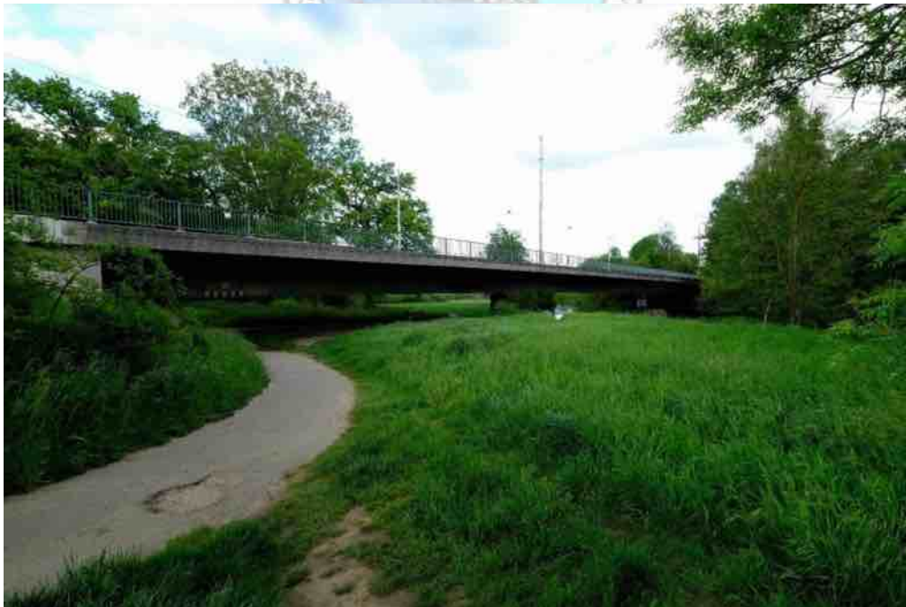
Abb. 90 Brücke Nr. 17, Aggerbrücke über die B 8 bei Troisdorf
