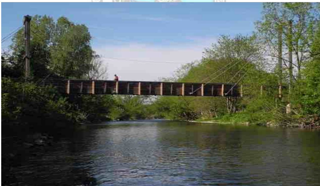
Abb. 83 Brücke Nr. 9 Fußgängerbrücke Donrath
