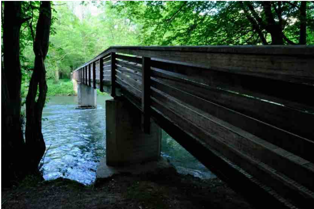
Abb. 79 Brücke Nr. 8 Fußgängerbrücke an der Dornhecke.
