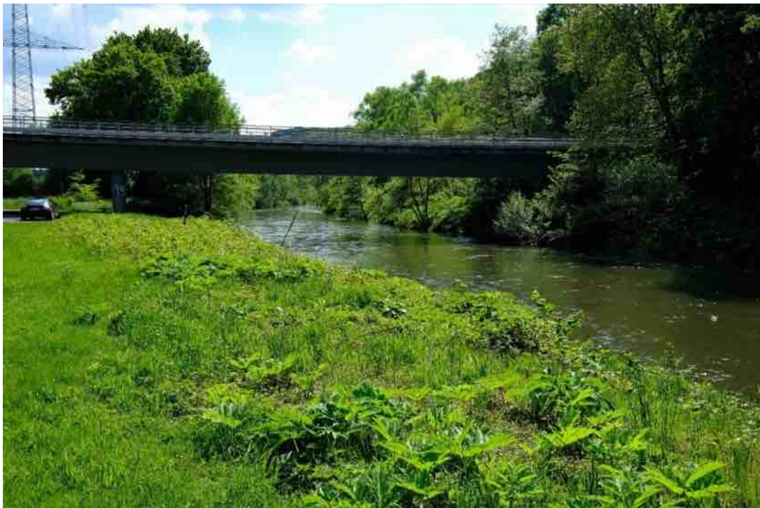
Abb. 87 Brücke Nr. 14 „Am Alten Fährhaus“
