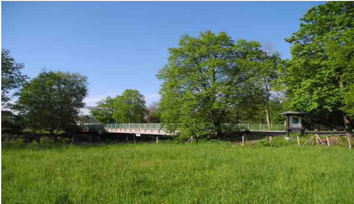
Abb. 73 Brücke Nr. 2 „Wahlscheider Brücke“
