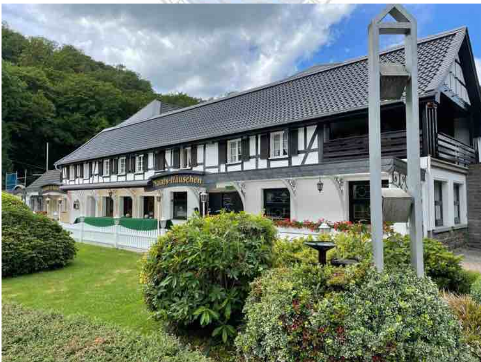
Abb. 57 Naafs-Häuschen, nach dem Ende der Renovierungsarbeiten im Juni 2021
