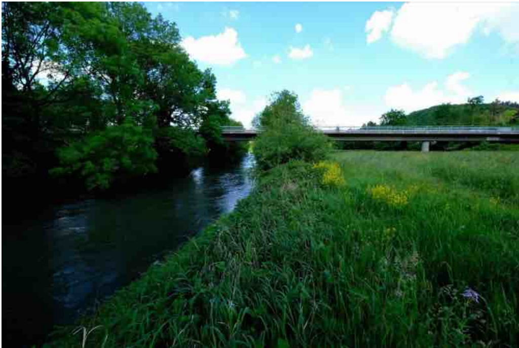
Abb. 85 Brücke Nr.11 Landstraße L 288 / Rösrath
