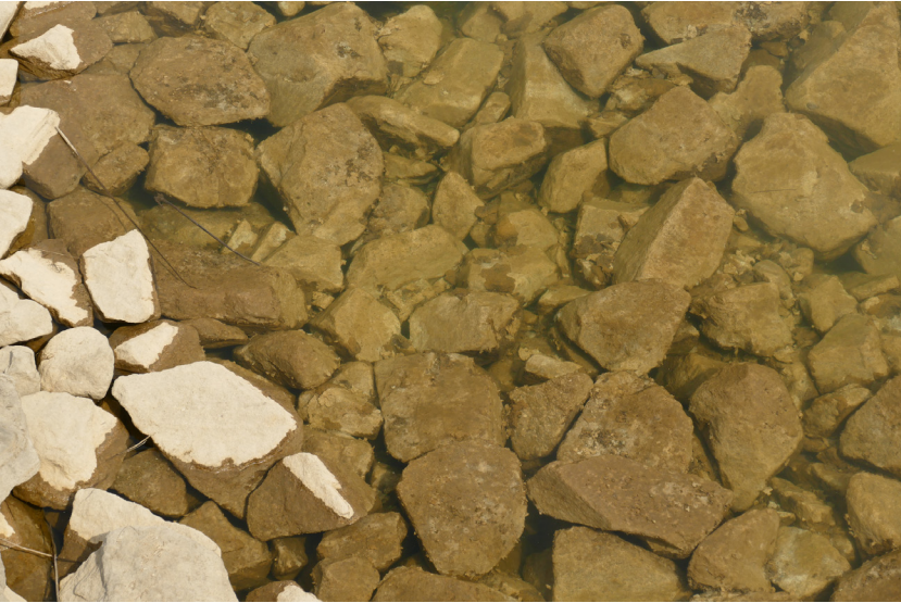
Abb. 3: Detailbild der Uferstruktur des Ein-/Auslassbeckens, bestehend gänzlich aus groben Wasserbausteinen, 16. April 2019. Foto: J. OTT.
